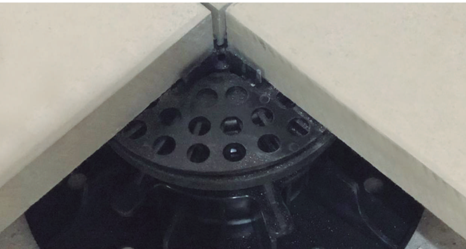
Exemplo de vista superior do sistema de piso elevado tetra-apoiado
